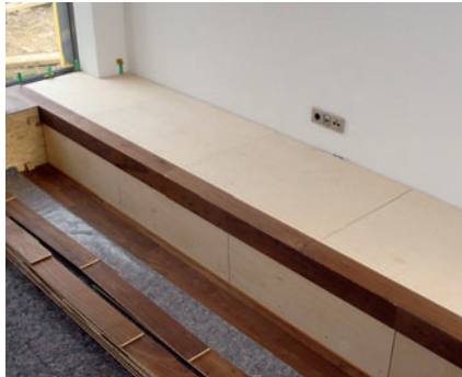
An den Stirn- und Beckenseiten wurden zunächst Multiplexplatten als Bodengrund verlegt
