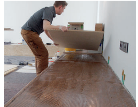
An den Längsseiten werden vorgefertigte Bodenteile mit einer Aufbauhöhe von ca. 18 mm verklebt
