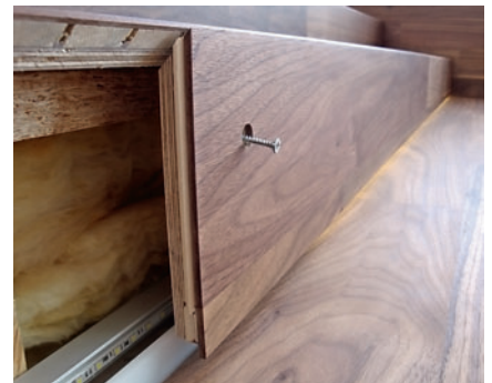
...das sich hinter der als Revisionsklappe dienenden untersten Setzstufe verbirgt. Diese ist...
