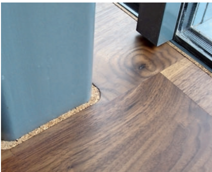
Auch Dehnungsfugen, Fenster- und Wandanschlüsse sind aus Kork, da es keine Sockelleisten gibt
