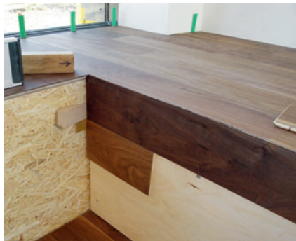
Auf den Multiplexplatten wird das auf Gehrung gesägt Parkett wie üblich verklebt. Dabei halten...
