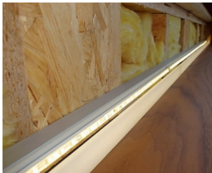
Das Treppenpodest ist mit Mineralwolle schallgedämmt und nimmt das Lichtband auf, ...
