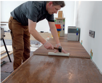
Wichtig ist dabei, die Fläche vorher passend aufzuteilen und ein fortlaufendes Dekorbild zu erzielen
